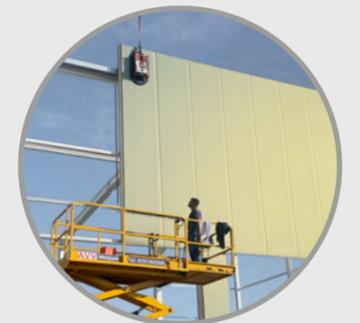
Verlegung von Sandwich-Paneelen mit einem Vakuum-Hebegerät
